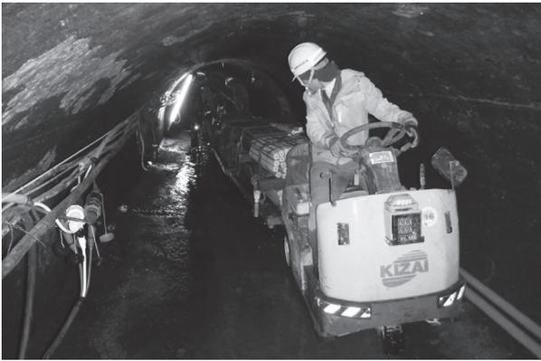
写真-4 バッテリーカーによる運搬
