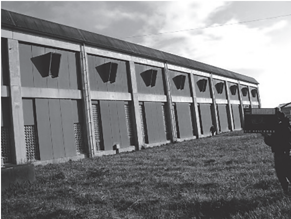
写真5 第一段揚水機場建屋（改修前）
