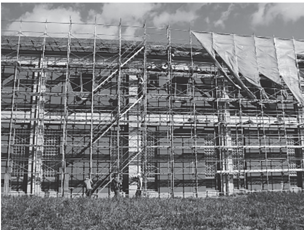
写真 13 建屋外壁のクラック補修
