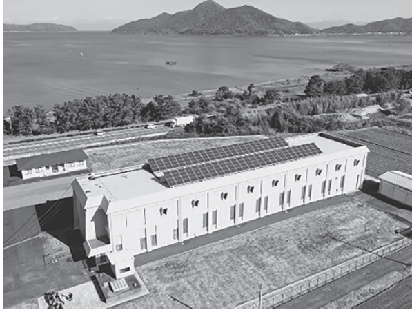
写真 22 屋上の太陽光発電システム
