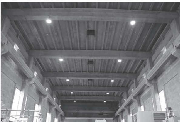
写真20 照明設備のLED化
