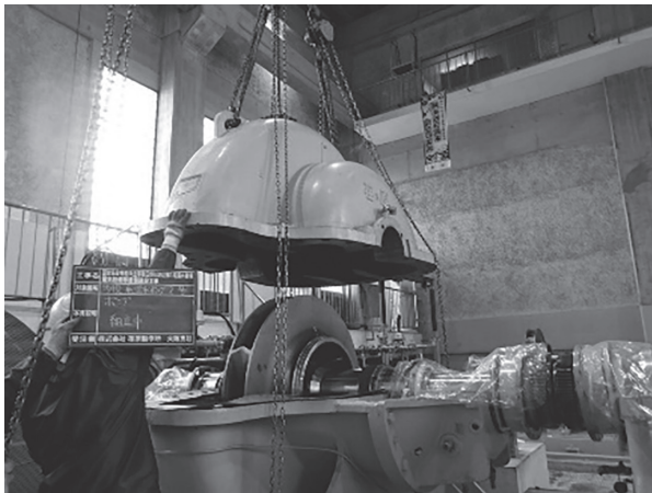
写真10 主ポンプ分解整備
