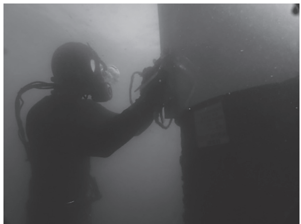
写真 15 水中作業によるペトロラタム被覆
