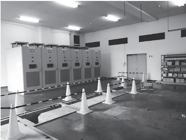
写真 12 特別高圧受電設備の更新
