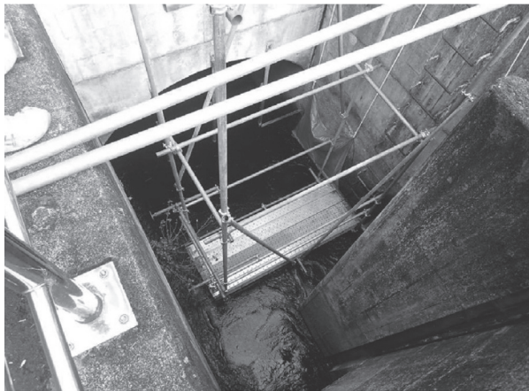
図-7 機材投入足場設置状況
