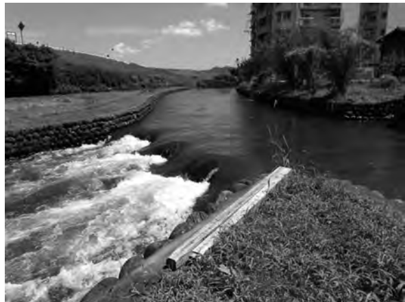
写真-2 角間天秤（角間分水工）
