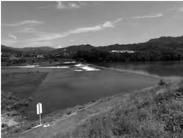
写真－3 大石堰の現況
