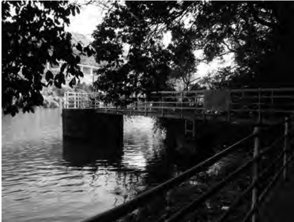
写真-4 現在の袋野取水口
