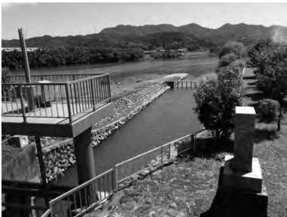
写真-1 大石・長野水道の取水門（旧・大石村長瀬）
