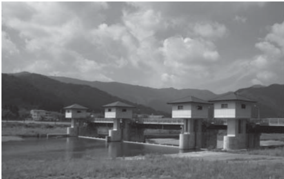
写真-1 八乙女頭首工
