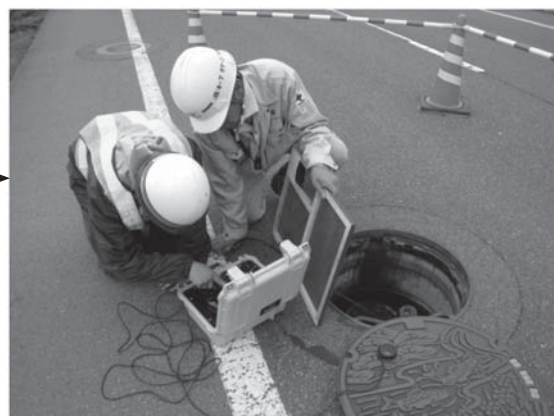
写真-8 SBRレシーバー確認状況
