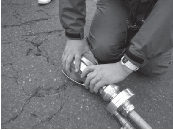
写真-10 投入器具(詳細)
