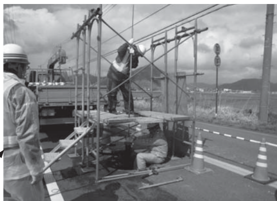
写真-7 SB投入状況
