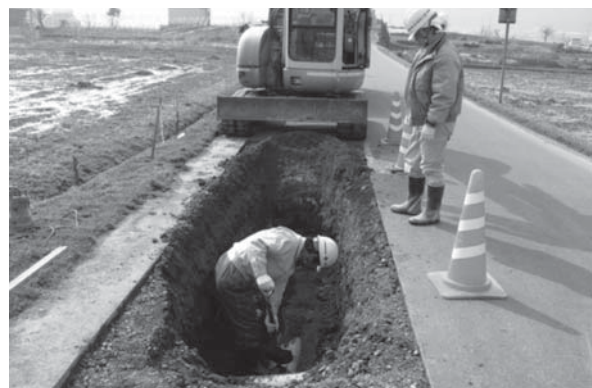
写真-4 開削工法による補修工事
